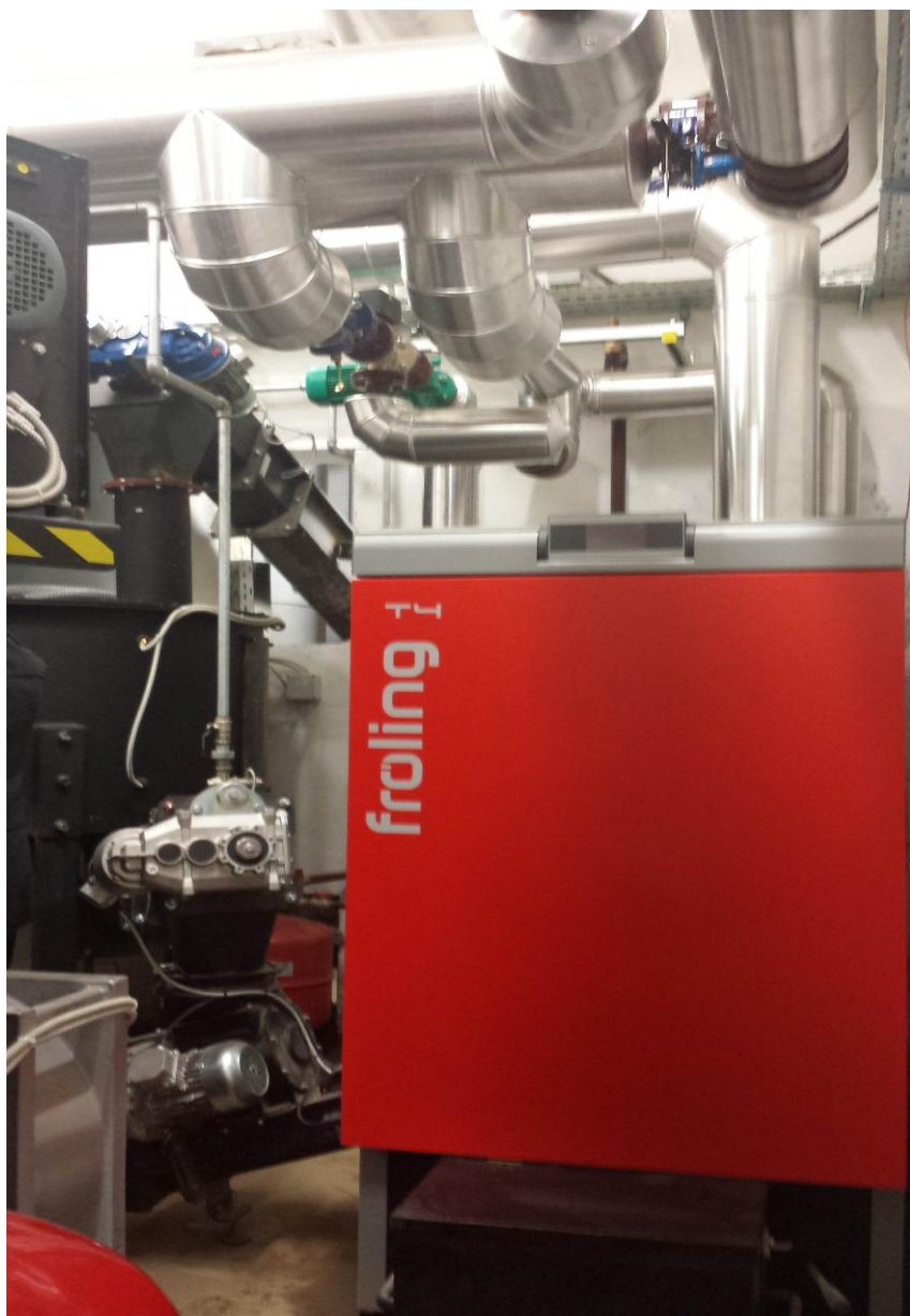
FROLING TURBOMAT 150 kW.
