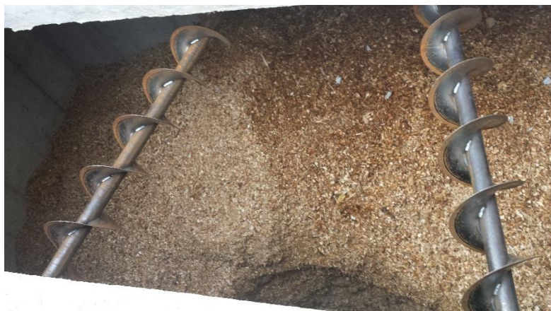
Slika 3: Zalogovnik lesne biomase s transportnim sistemom.
